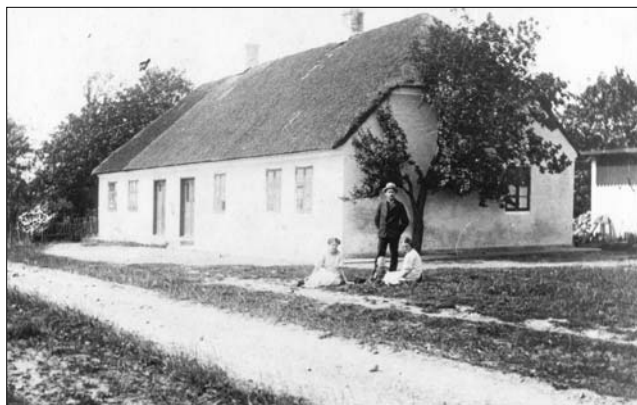
Guldbæk skole 1909. Taget i vestre ende ses anderledes end det øvrige. Nok en følge af arbejdet i 1871. Til højre ses det ny tørvehus.
